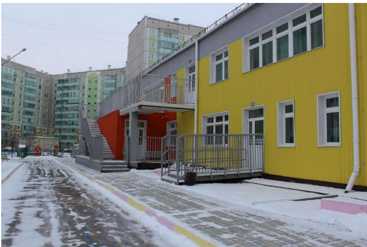
ФОТО № 9 НАРУЖНЫЕ ЛЕСТНИЦЫ ЭВАКУАЦИЯ
