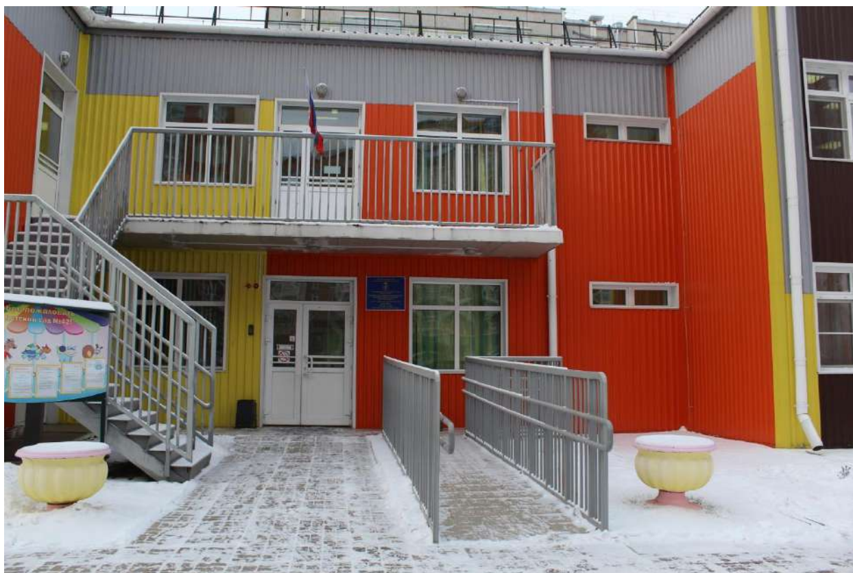
ФОТО № 1 ЦЕНТРАЛЬНЫЙ ВХОД
