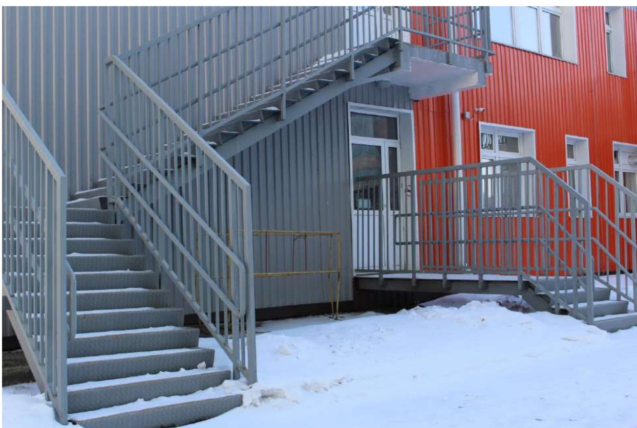
ФОТО № 8 НАРУЖНАЯ ЛЕСТНИЦА ЭВАКУАЦИЯ 2 ЭТ.
