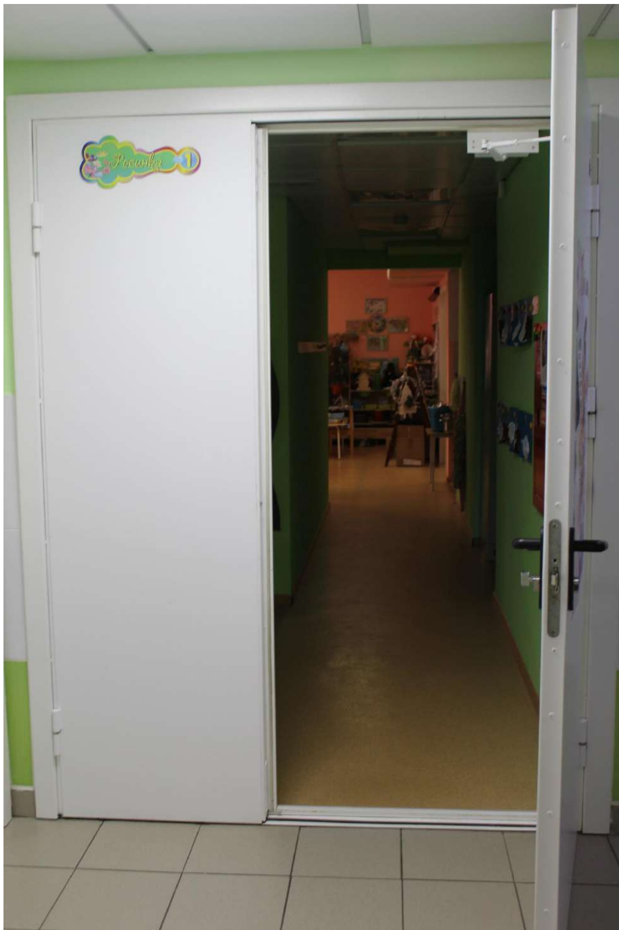
ФОТО № 32 ГРУППОВАЯ ЗОНА ОБСЛУЖИВАНИЯ
