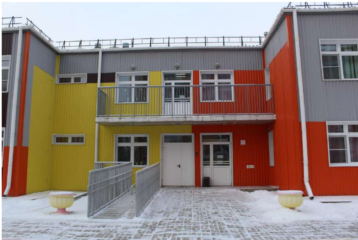
ФОТО № 2 ЦЕНТРАЛЬНЫЙ ВХОД
