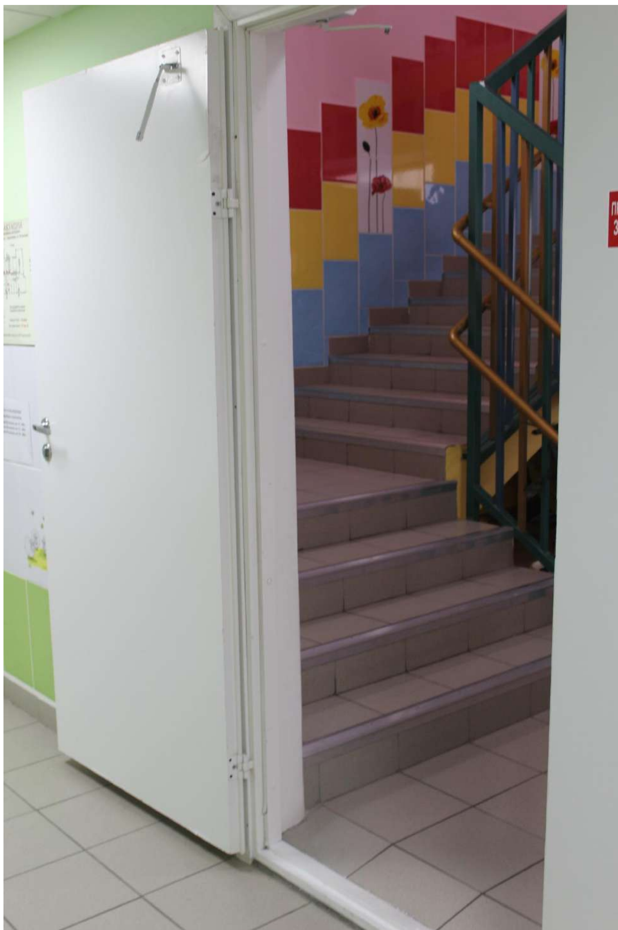
ФОТО № 16 ЛЕСТНИЦА ВНУТРИ ЗДАНИЯ
